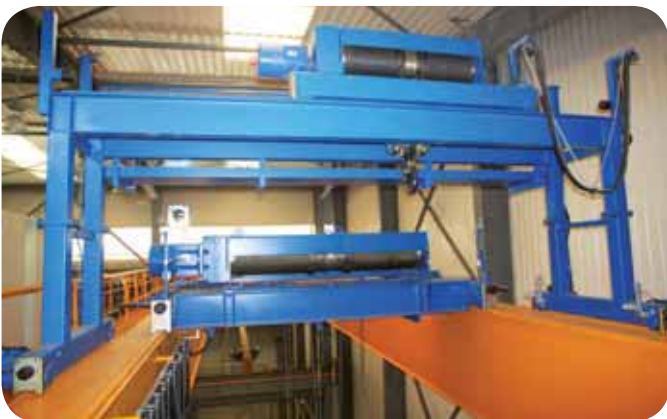
TOPP MONTERT LØPEKATT
